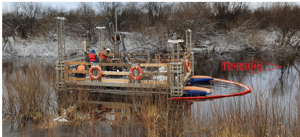
Рисунок 7 – Общий вид буровых работ с придонных (неподвижных) оснований (платформ) с применением бонового заграждения
