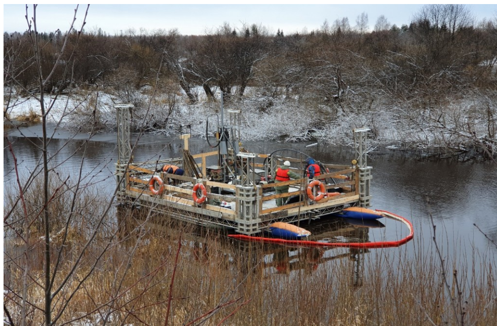
Рисунок 1 – Бурение скважин с придонных (неподвижных) оснований (платформ)
