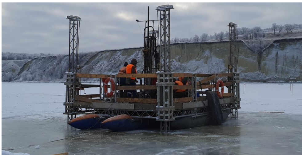
Рисунок 6 – Бурение с использованием придонной платформы
