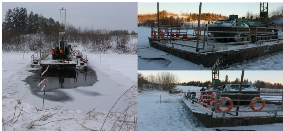
Рисунок 8 – Бурение с понтона в ранее вырезанной полынье
