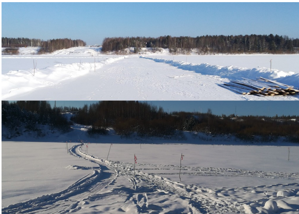
Рисунок 4 – Обозначенные подходы, подъезды и ледовые дороги от берега сигнальными вехами
