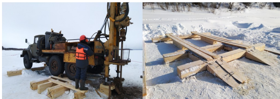
Рисунок 5 – Практикуемые формы прочных оснований при работе на колесной технике
