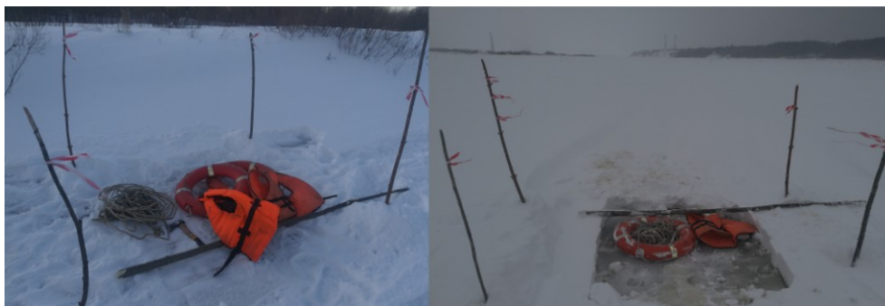
Рисунок 1 – Примеры «Охранных» постов, фактически используемых при производстве работ на льду
