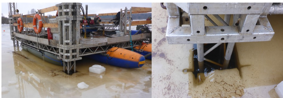
Рисунок 7 – Установка закорных свай в заранее выпиленные лунки на месте производства работ
