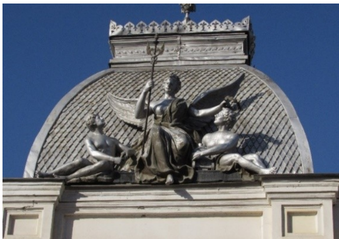
Рисунок 8 – Элементы фасада здания банка 1894 г. по ул. Эспланадной г. Астрахани (фото авторов)
