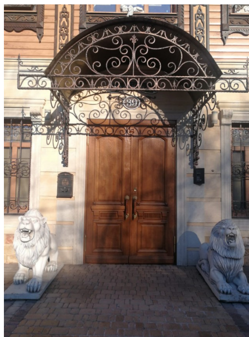
Рисунок 7 – Фасад малоэтажного жилого дома по ул. Шаумяна г. Астрахани (фото авторов)
