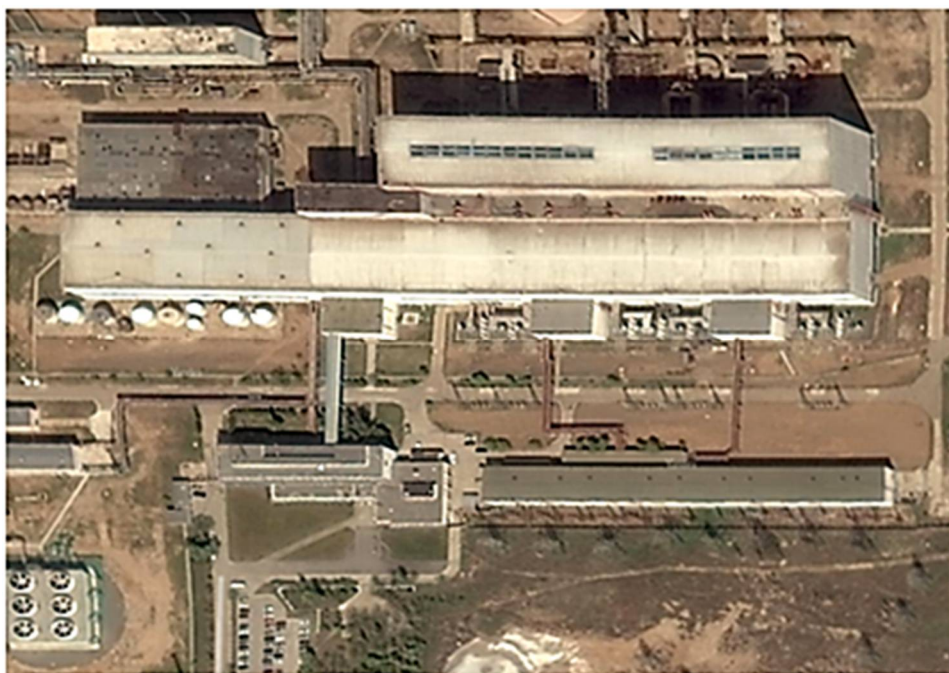
Рис. 1. Основной корпус ТЭЦ-2
