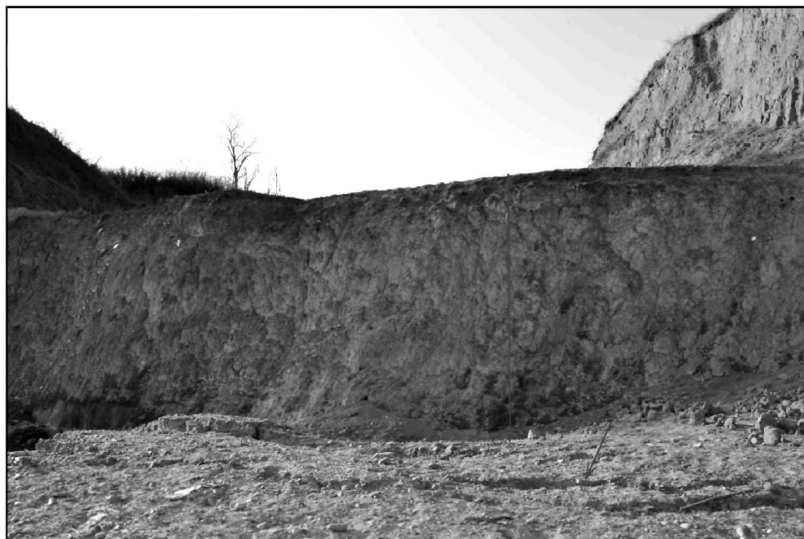
Рис. 1. Активизация оползневого участка
